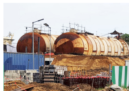
Chantier Dépôt de Gaz de Toamasina Source: OMH
